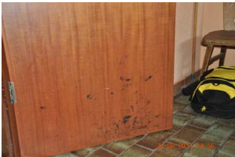
Foto Nr. 5: Verschmutzung von Türen in Umkleidekabinen durch Abrieb des SBR-Granulates
